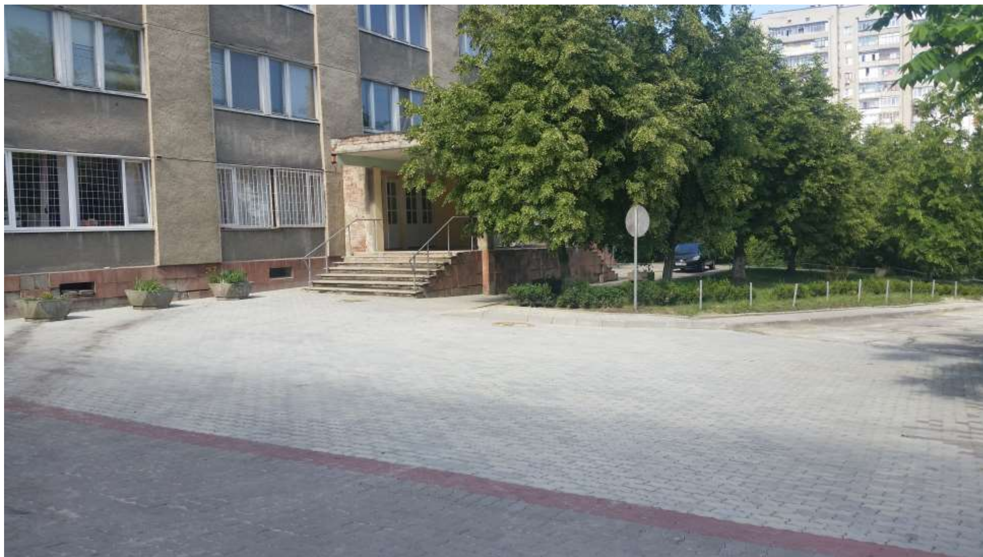
Поточний ремонт асфальтного покриття.
