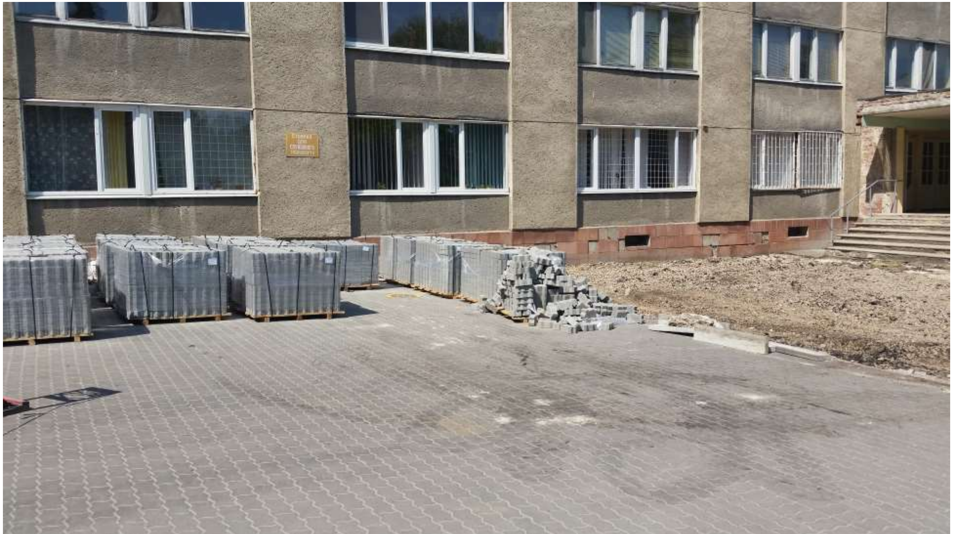
Поточний ремонт асфальтного покриття.
