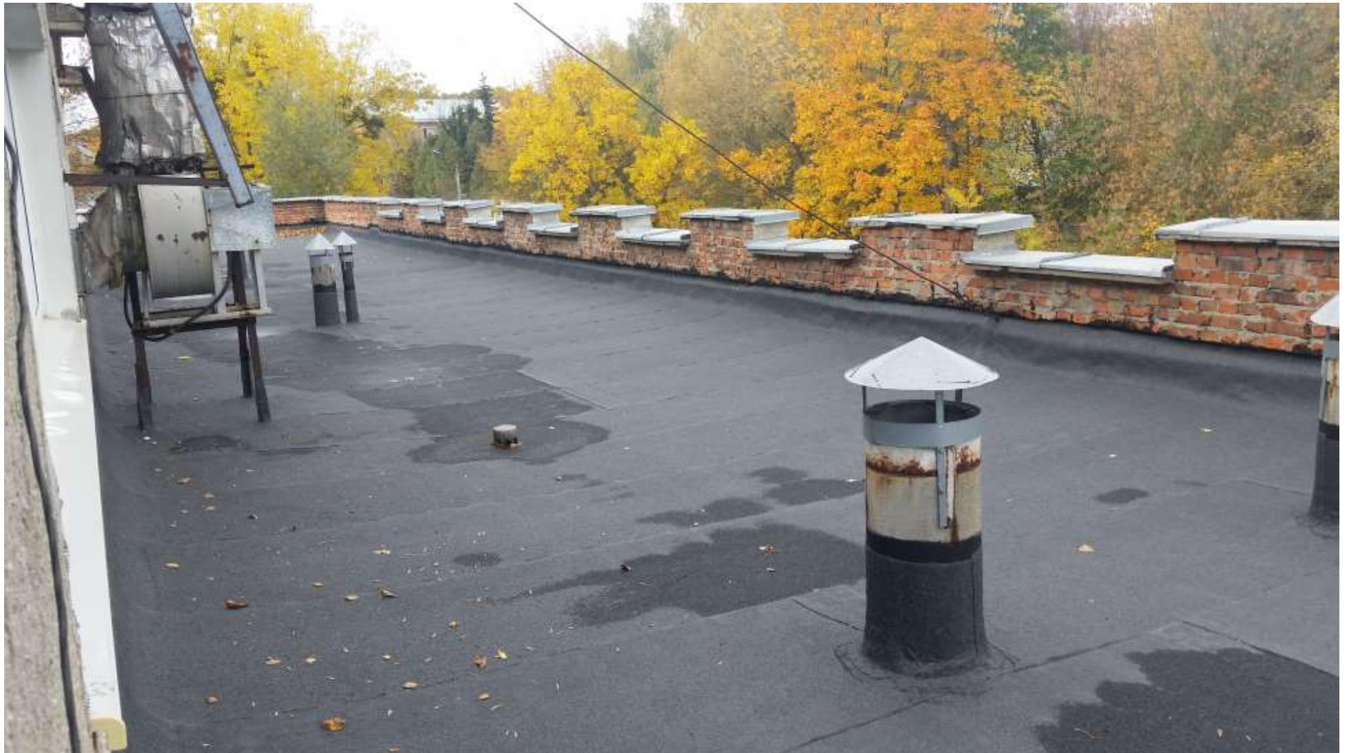
ремонт даху харчоблоку
