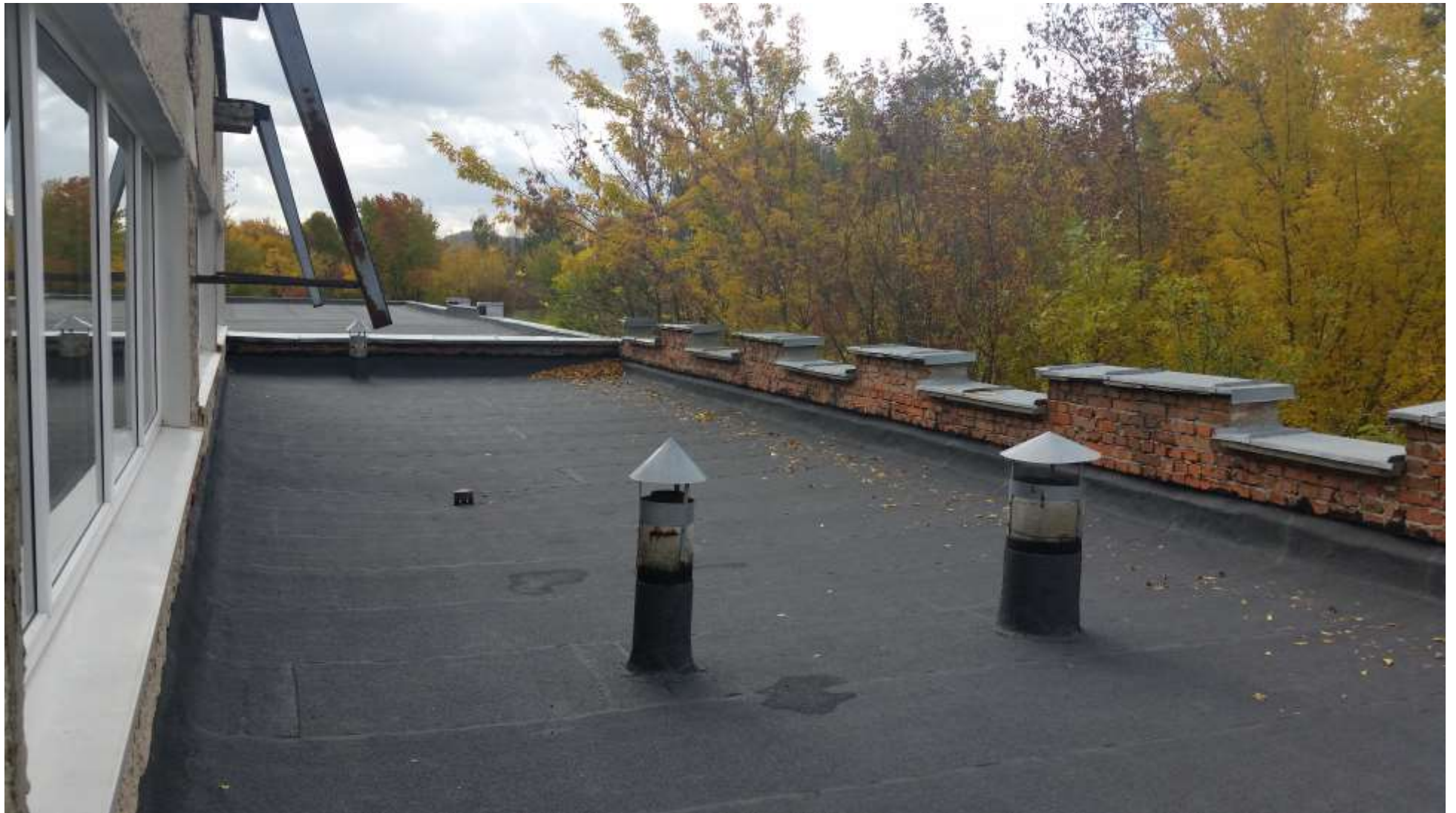
ремонт даху харчоблоку
