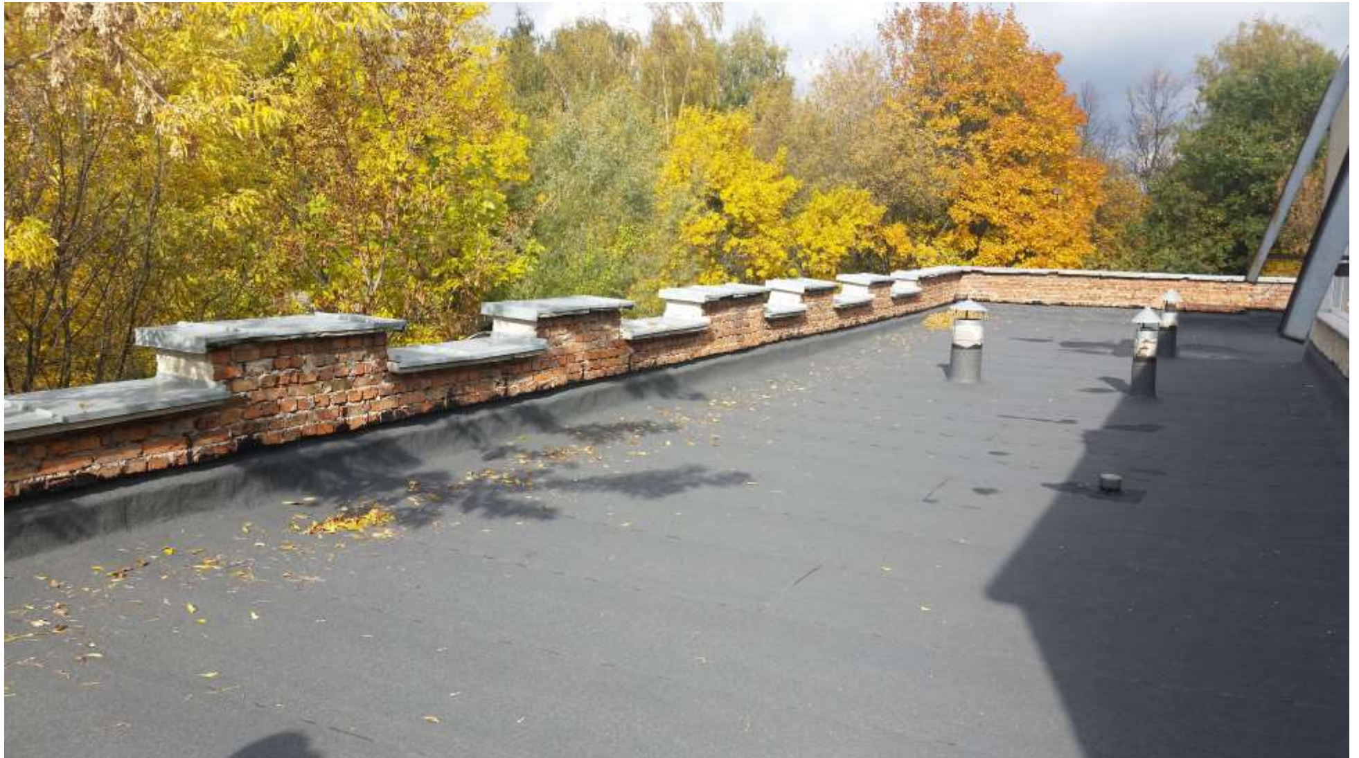
ремонт даху харчоблоку
