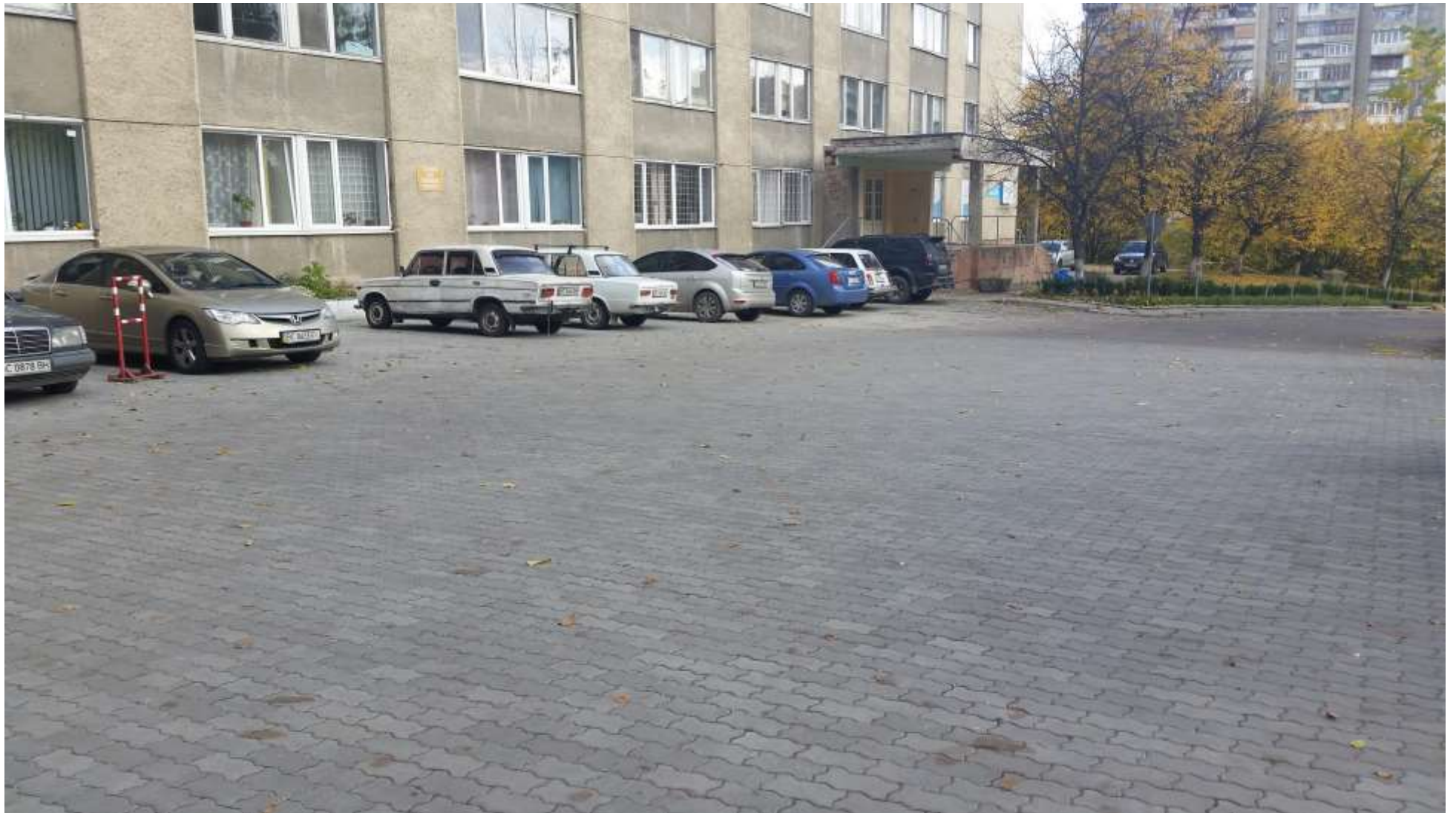
ремонт асфальтного покриття
