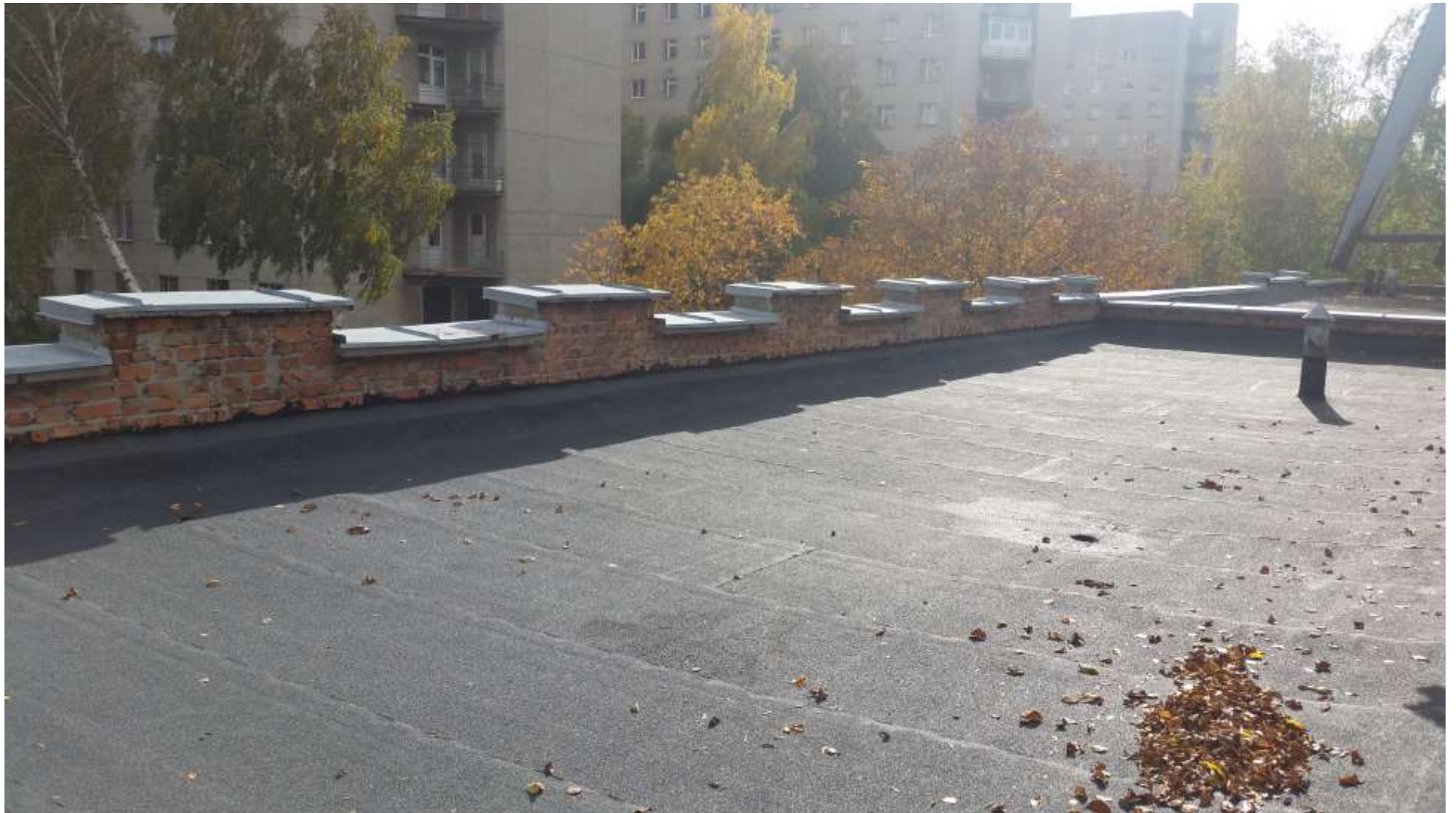
ремонт даху харчоблоку
